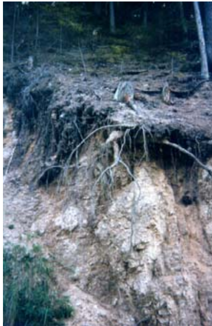
Hangrutsch im Zuge eines Forststraßenbaus
