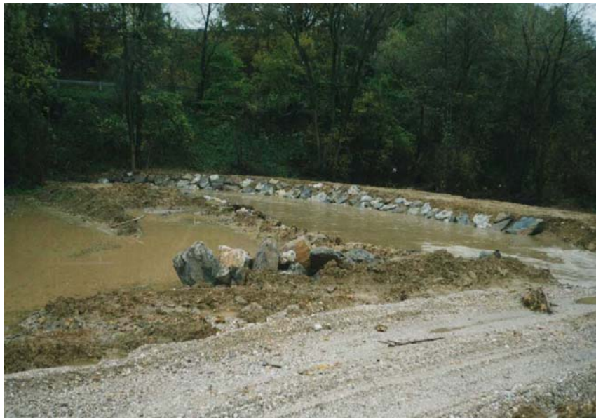
Bach-Umleitungen in Blindenmarkt
