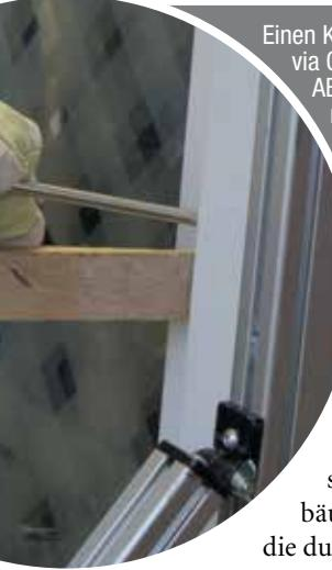
Einen Kreis aus dem Fenster schneiden und diesen via Glasheber entfernen – das funktioniert laut ABUS nur bei James Bond. Einbrecher arbeiten mit dem Hebelgesetz. Der Täter platziert einen Schraubenzieher zwischen Fensterrahmen und -flügel, drückt auf den Griff und ist im Gebäude.
