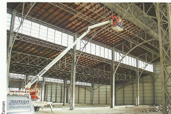
Die 2006 restaurierte Marxhalle als Beispiel für die Anpassung historischer Bauwerke an aktuelle Anforderungen und eine neue Nutzung.
