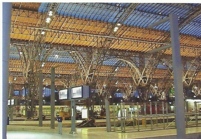
Sanierung der historischen Dachkonstruktion über dem größten Kopfbahnhof Europas, dem Leipziger Hauptbahnhof, durch Waagner-Biro.
