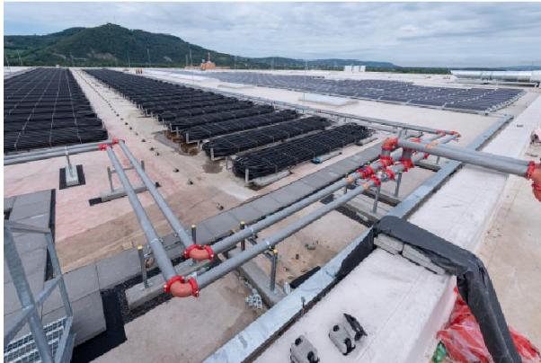
Das gesamte Dach wird bis 2025 mit mehr als 170 PV-Modulen bestückt, die zu vier Anlagen mit je 200 KW/p zusammengeschalten werden. Ein Viertel des generierten Stroms soll selbst verbraucht, der Rest ins Netz eingespeist werden. (Foto: IKEA)
