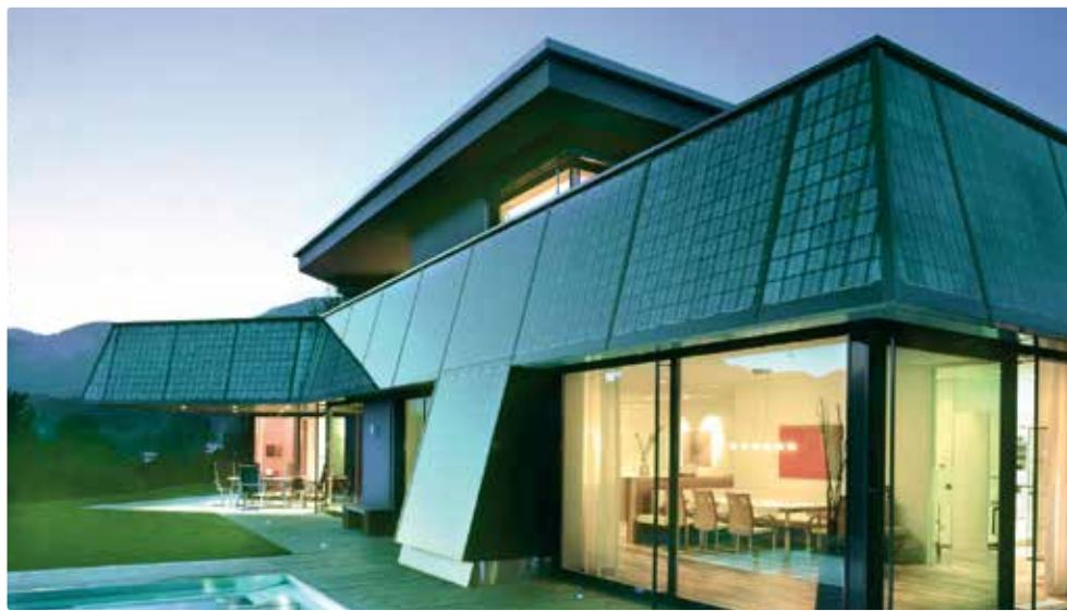
Neben Prüfung und Zertifizierung stellen Forschungsaktivitäten eine wichtige Grundlage für neue, innovative Lösungen dar: Ziel des interdisziplinären FEI-Projekts PV@Fassade ist die bessere Integration von PV-Elementen in die Fassade, z.B. durch Verklebung der PV-Aktivmaterialien mit Fassadenelementen.
