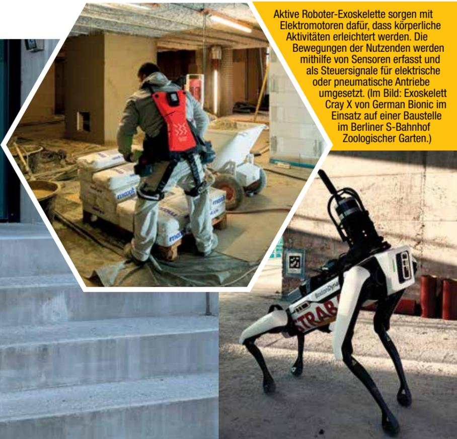
Aktive Roboter-Exoskelette sorgen mit Elektromotoren dafür, dass körperliche Aktivitäten erleichtert werden. Die Bewegungen der Nutzenden werden mithilfe von Sensoren erfasst und als Steuersignale für elektrische oder pneumatische Antriebe umgesetzt. (Im Bild: Exoskelett Cray X von German Bionic im Einsatz auf einer Baustelle im Berliner S-Bahnhof Zoologischer Garten.)
