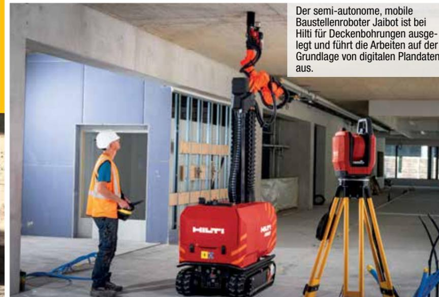
Der semi-autonome, mobile Baustellenroboter Jaibot ist bei Hilti für Deckenbohrungen ausgelegt und führt die Arbeiten auf der Grundlage von digitalen Plandaten aus.
