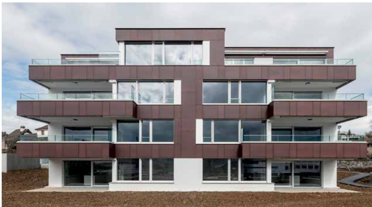
Die Modulbauweise mit nachhaltiger Montageart wie Einhängen, Schrauben oder Klemmen erleichtert das Recycling und den Tausch von Fassadenplatten (im Bild: Fassaden-PV-Module mit braunem Siebdruck).
