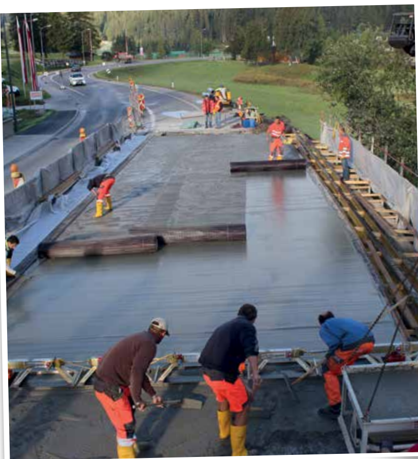
Mit Textilbeton wird die Fahrbahnplatte bei einem Projekt in Seefeld verstärkt.
