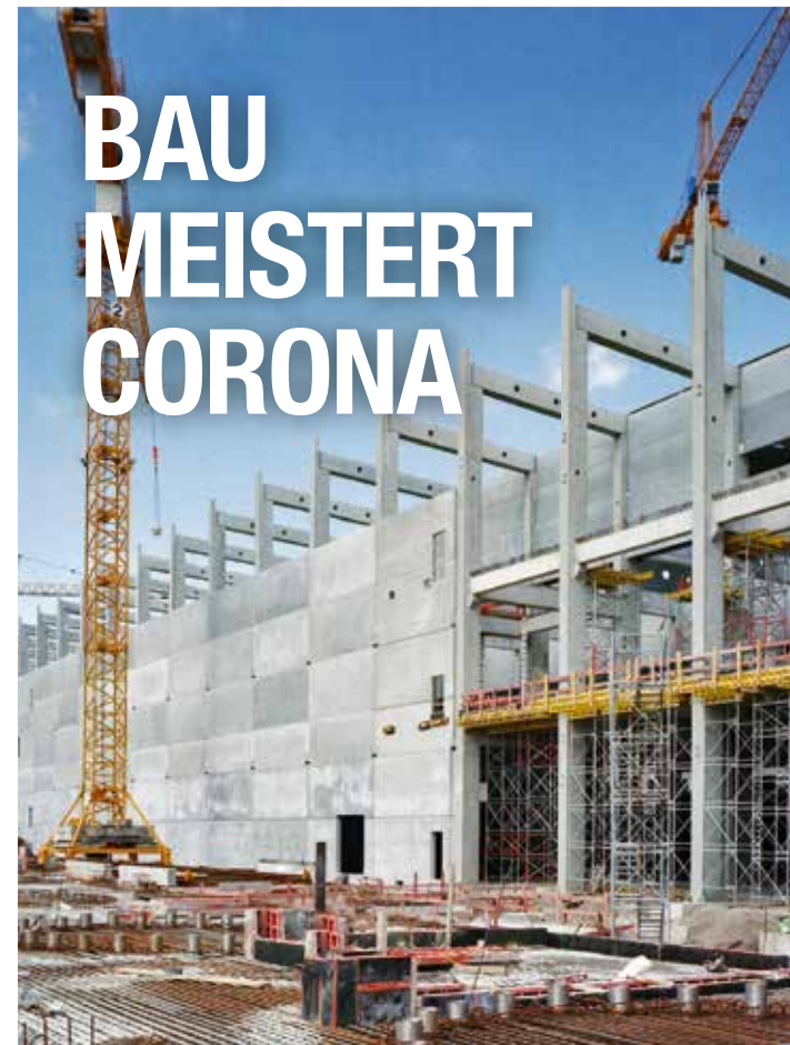
Fotos: BauAkademie, Saubermacher, Wienerberger
