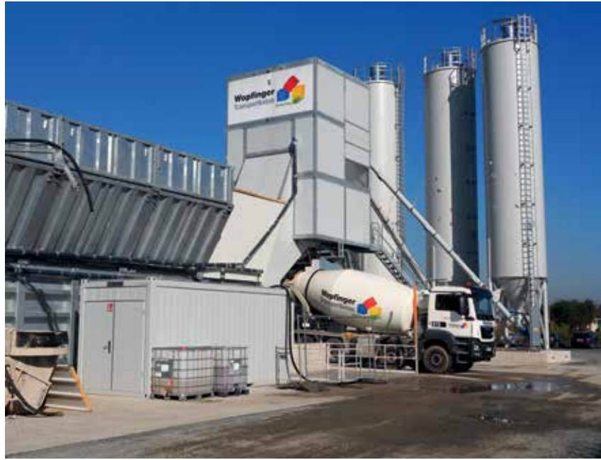
Beton vor Ort auf der Baustelle situationsbezogen herzustellen, spart wesentlich an Zeit und Kosten. Wopfinger Transportbeton setzt auf mobile Mischanlagen bei Infrastrukturprojekten wie der S7 Fürstenfelder Schnellstraße oder dem Koralmtunnel.
