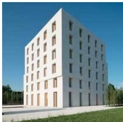
Die graue Energie von Materialien gewinnt immer mehr an Bedeutung im Hinblick auf die Gesamtenergieeffizienz von Gebäuden. Bauwerke müssen ganzheitlich über den Lebenszyklus betrachtet werden, hinsichtlich Energie- und Materialeffizienz. (Im Bild: energieeffizientes Ziegel-Bürogebäude »2226« in Lustenau)
