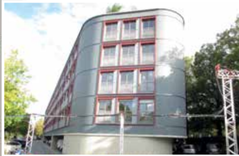
▲ Der steigende Bedarf an bezahlbarem Wohnraum stellt Planer und Industrie vor neue Herausforderungen. Ein Pilotprojekt bildet der Holzhybridbau Dantepark der Gewofag als Überbau eines städtischen Parkplatzes. Damit kann die bereits versiegelte Fläche doppelt genutzt werden, der Großteil der Parkplätze blieb erhalten. Der Quadratmeterpreis liegt bei 9,40 Euro pro Monat.
