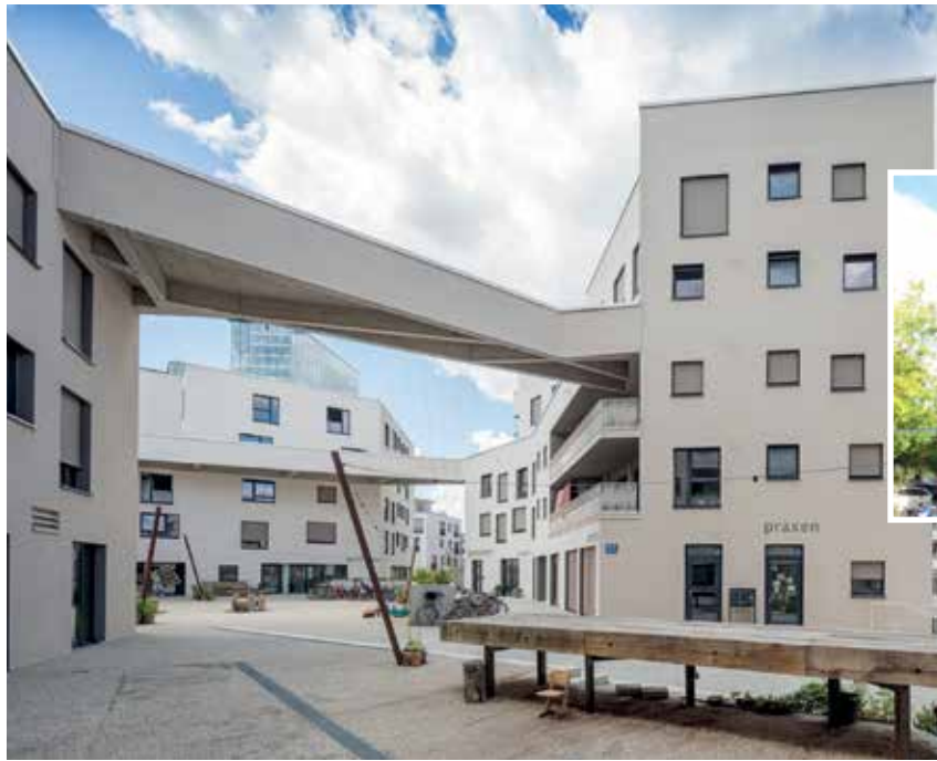
◀ Beim Projekt WagnisART verbinden Brücken und Stege fünf freistehende Passivhäuser in Stahlbeton-Holz-Hybridbauweise. Die Miete liegt je nach Einkommen zwischen 5,65 und 13 Euro. Gefördert wird nach EOF und München Modell Genossenschaften.
