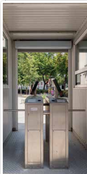
Um die SVA-Baustelle betreten zu dürfen, müssen dort tätige Personen sich registrieren, erhalten einen digitalen Ausweis und werden mittels Ausweis und intelligenter Terminals im Zugangskontrollbereich erfasst.
