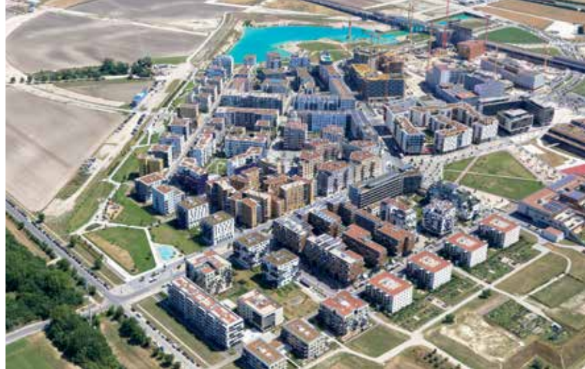
In der Seestadt Aspern konnten durch eine ausgeklügelte Baustellenlogistik und direkte Wiederverwertung von Aushubkies über 100.000 Lkw-Fahrten und 3 Mio. Euro Transportkosten eingespart werden
