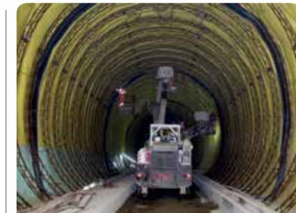
Mit der Tunnelkette Granitztal hat auch die ÖBB ein erstes BIM-Pilotprojekt laufen.
