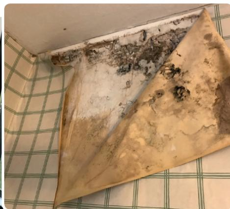
Schimmelbefall entsteht bei erhöhter Feuchtigkeit nicht nur an Stellen, die sofort ins Auge fallen, sondern insbesondere verdeckt an schlecht belüfteten Stellen wie etwa hinter Fußleisten, Schränken, Tapeten oder Verkleidungen.
