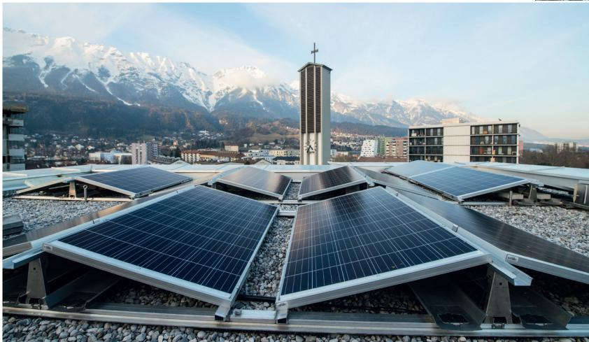
In der Reichenauer Straße in Innsbruck wurde tirolweit die erste gemeinschaftliche PV-Anlage umgesetzt. 133 Solarmodule mit einer Fläche von 223 m<sup>2</sup> erzeugen rund 38.000 kWh Sonnenstrom. Damit kann etwa ein Fünftel des Durchschnittsverbrauchs der teilnehmenden Haushalte gedeckt werden. 38 von 49 Parteien konnten für die Teilnahme überzeugt werden.
